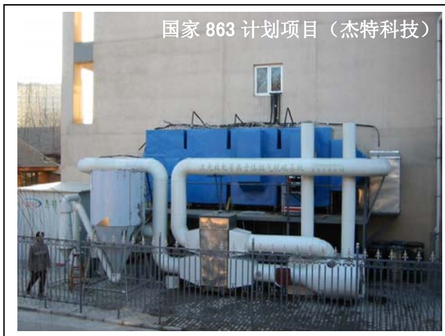
图 1, 12,000 \text{Nm}^3/\text{h} 高频交直流叠加电源及等离子体反应器
